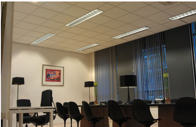
Kantoren complex Willemstraat Breda. 1500 m2 LED verlichting.
